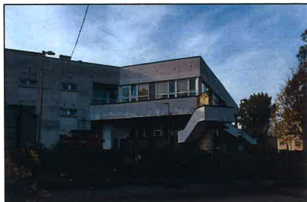
Widok od ul. Elekcyjnej.
