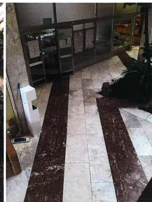
IL. 35. Widok z góry na hol przy wejściu.
